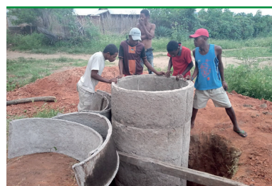
Brunnenbau in Berenty
