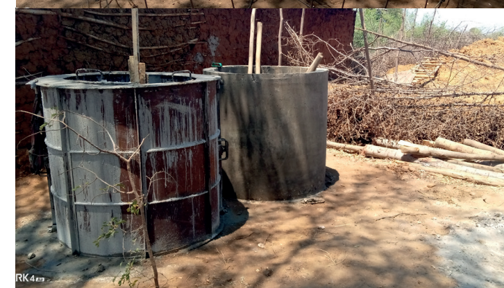
Der Bau weiterer Brunnen hat bereits begonnen.
