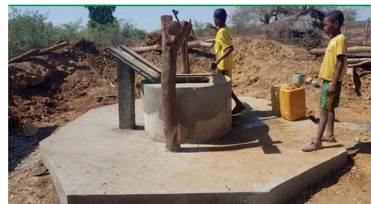
Der Brunnen ist fertiggestellt.
