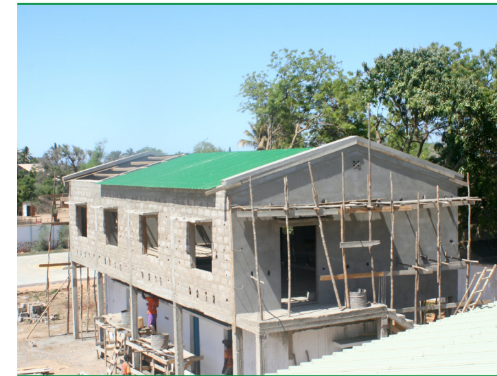
Die Aufstockung des Gebäudes ist fast abgeschlossen.
