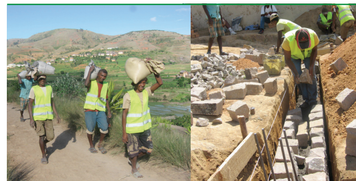
Links: Da der Bauplatz schlecht zugänglich ist, wurde das Baumaterial von Hand transportiert. Rechts: Ein einfaches, aber zweckmässiges Fundament für das zweite, grössere Gebäude.
