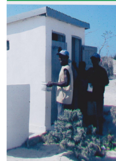
Zur Erneuerung der Schulhäuser in Beheloka gehörte 2016 auch das Erstellen sanitärer Einrichtungen.
